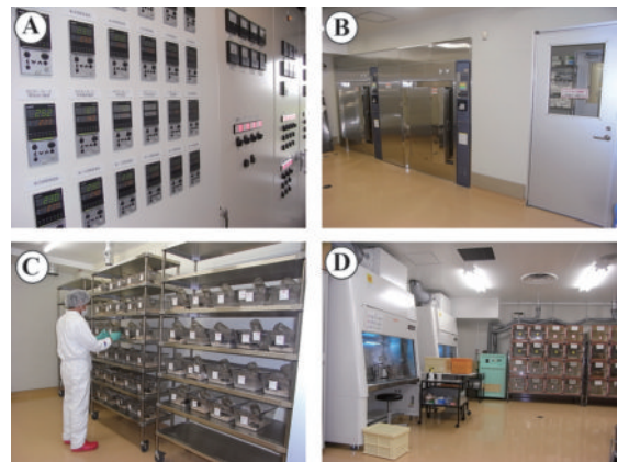
図1. 動物実験施設の設備
